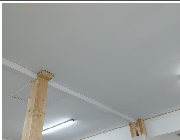
Déclaré - : RDC / Salle 1 - Enduit projeté - EP- (Présence d'amiante)
