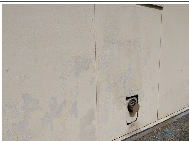
Déclaré - : Extérieur / Façades - Plaque plane - EP- (Présence d'amiante)
