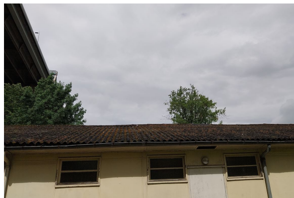
Déclaré - : Extérieur / Toiture - Plaque ondulée - EP- (Présence d'amiante)
