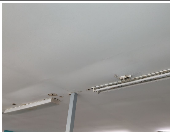
Déclaré - : RDC / Salle 2 - Enduit projeté - AC1- (Présence d'amiante)
